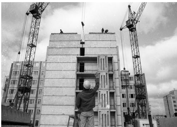
Рисунок 6. Строительство нового района. 1987 год
