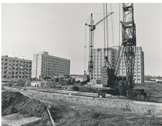
Рисунок 7. Строительство нового района. 1987 год
