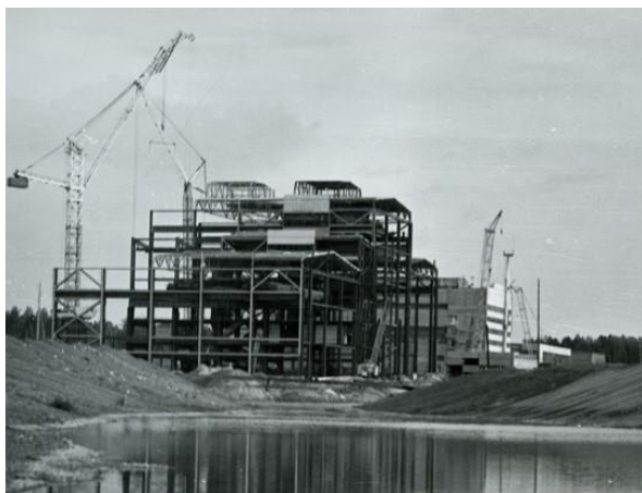
Рисунок 5. Монтаж корпуса под первый энергоблок Сургутской ГРЭС-1
