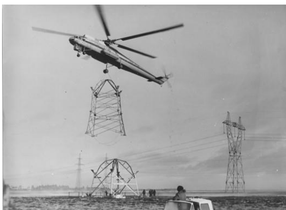
Рисунок 8. Строительство переходной опоры ВЛ 220 КВ. 1960-е годы
